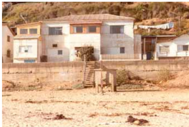
Foto 4. El edificio del laboratorio de Montemar visto desde la playa
